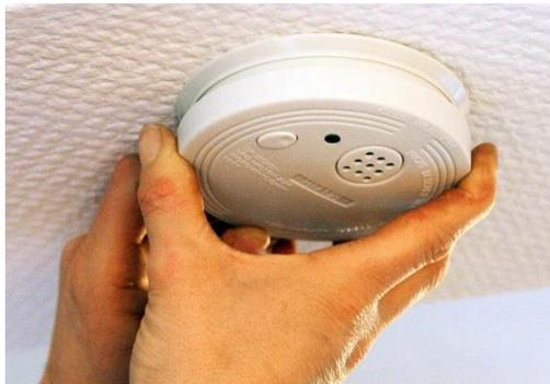
Sie werden oben an der Decke angebracht. Die Rauchmelder piepen, wenn es raucht oder Feuer brennt. In der Küche muss kein Rauchmelder angebracht werden. Rauchmelder sind rund und die Halterung wird angebohrt. Rauchmelder halten an der Decke, indem sie verschraubt oder verklebt werden. Verantwortlich für den Einbau ist der Eigentümer oder Vermieter der Wohnung. Der Rauchmelder funktioniert mit Batterien.
